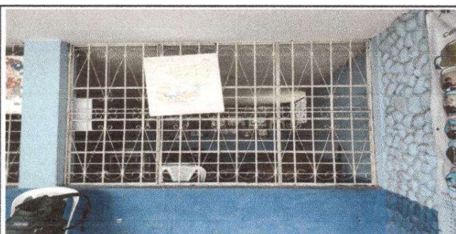
Foto 5: Reparación y Fabricación de balcones
