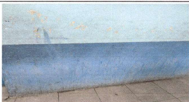
Foto 3: Pintura en Muro Externo e Interno
