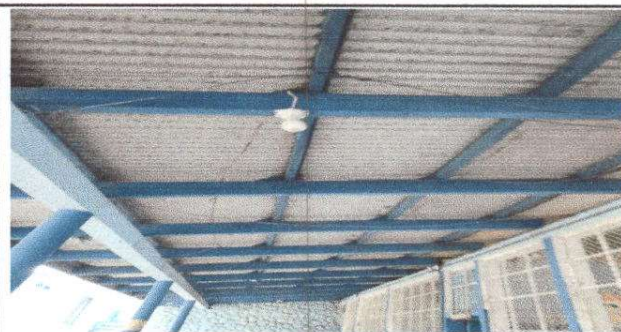
Foto 4: Sustrucción de lamparas LED
