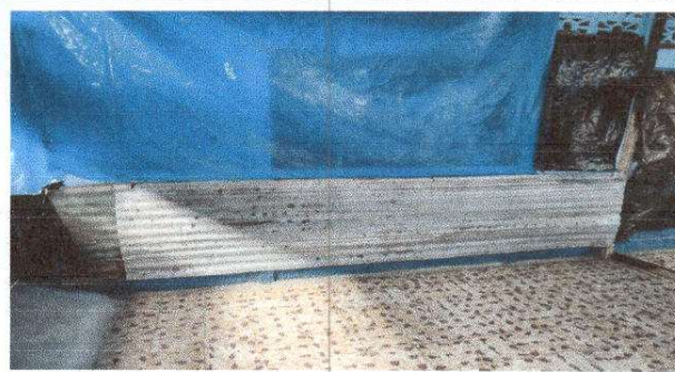
Foto 8: Reparación de pared
