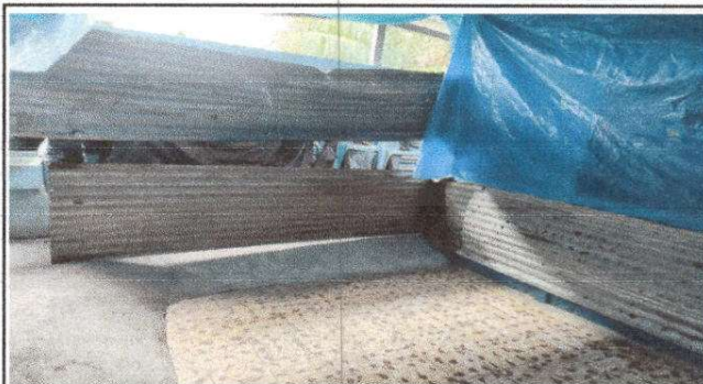
Foto 2: Sustrucción de piso de cemento líquido
