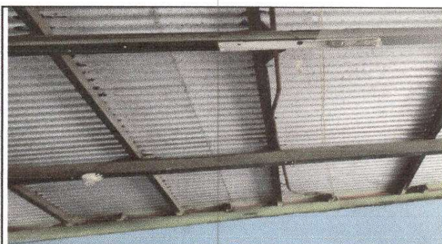
Foto 10: Instalación de unidades de luz
