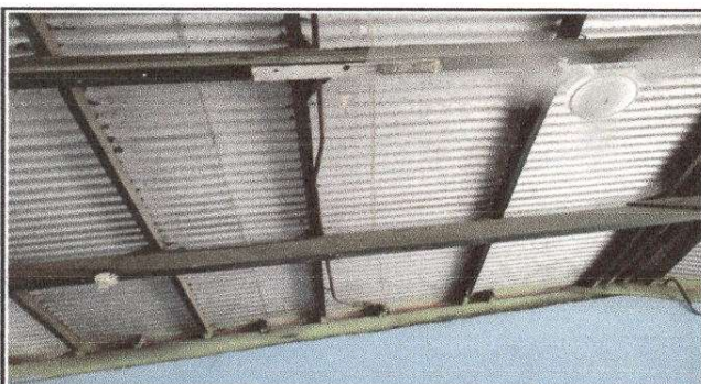
Foto 9: Sustrucción de Lamparas LED
